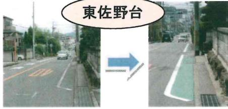
東佐野台に住む保護者から、子供が佐野台小学校に通学の際、走行車両との距離が非常に近く、危険なので安全に通学できるようにとの要望を受け、従来の白線に加えてグリーン(緑)の舗装を実現。
