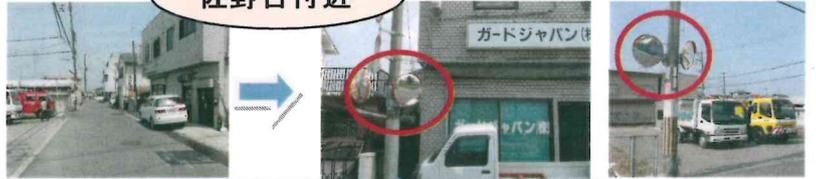
府営佐野台住宅から 13 号線に抜ける道路において、従来カーブミラーが 1 ヶ所の片面のみで、見通しが悪かったため、カーブミラー増設の要望を受け、設置を実現。
