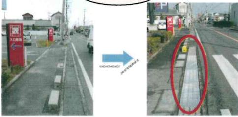
府営鶴原住宅前のスーパー松源さん横の側溝すき間に、車椅子の車輪やお年寄りの方の杖がはさまり、危険であるとの相談を受け、横断歩道前の側溝(グレーチング)の幅を狭くする作業を要請し完了。
