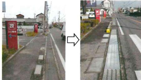
府営長坂住宅のご婦人より、スーパー松源横の側溝の溝に、車椅子の車輪やお年寄りの方の杖が入り、危険であるとのご相談を受け、横断歩道前の側溝(グレーチング)の幅を狭くする作業を要請し、完了。(平成20年11月)
