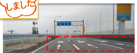
国道357号線 舞浜大橋下り線にそれぞれ3箇所敷設して頂きました
