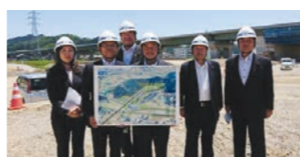
高富I.C工事現場で
