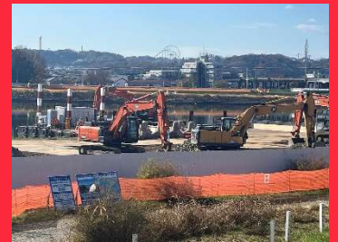
河道掘削の様子
