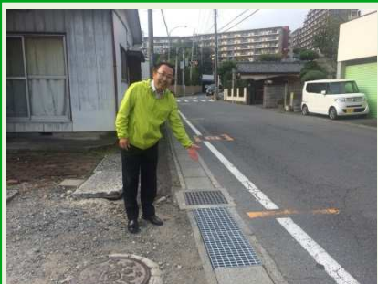
側溝フタをグレーチングに変更
