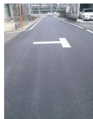
↑ 劣化した道路が舗装さ れました (一番町4丁目)
