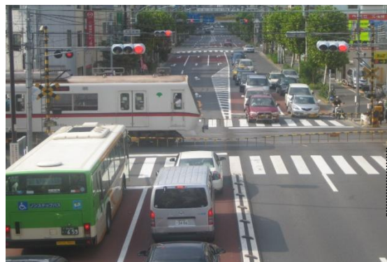
←立体化工事が始まった京成曳舟駅出入口(明治通り側)
