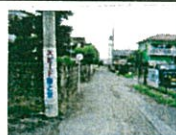
カーブミラー設置
