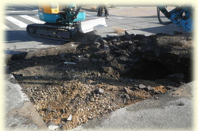
【三重県四日市市の空洞調査の例】
