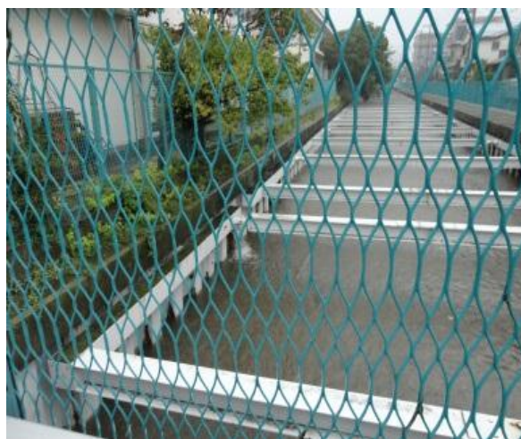
限界水位に近づく稲毛小学校脇の都市下水道
