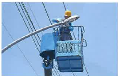
リース方式で道路照明灯をLED化。(年間経費約2.7億円削減)
